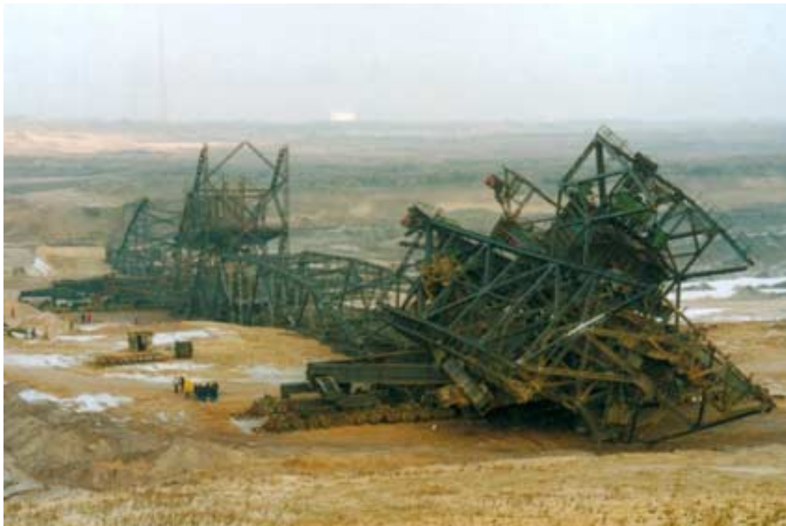
Sprengung der Abraumförderbrücke im Tagebau Zwenkau (Foto: LMBV mbH)
