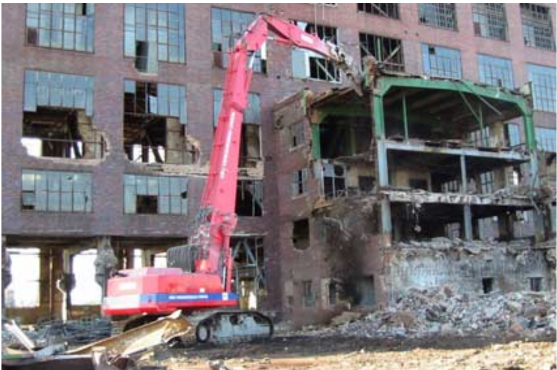
Abbruch von Anlagen im Betriebsgelände Espenhain (Foto: LMBV mbH)
