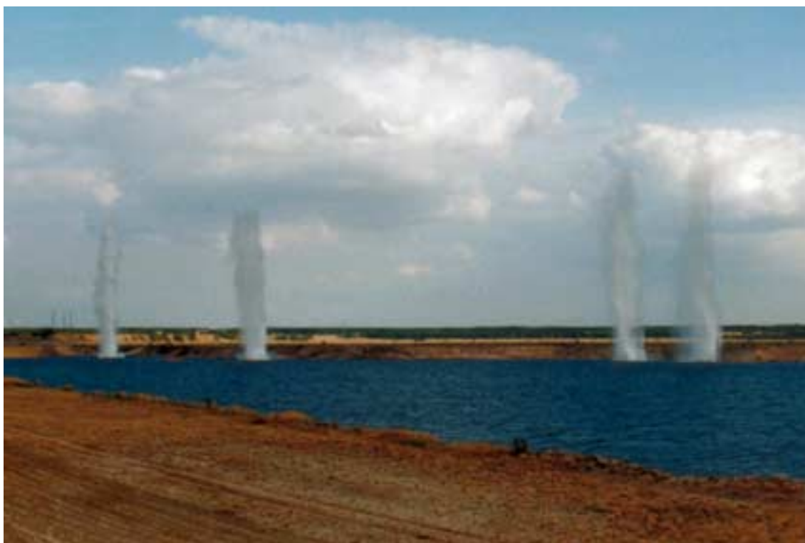
Sprengverdichtung - Testsprengungen vor der Innenkippe des Tagebaus Scheiße (Foto: LMBV mbH)
