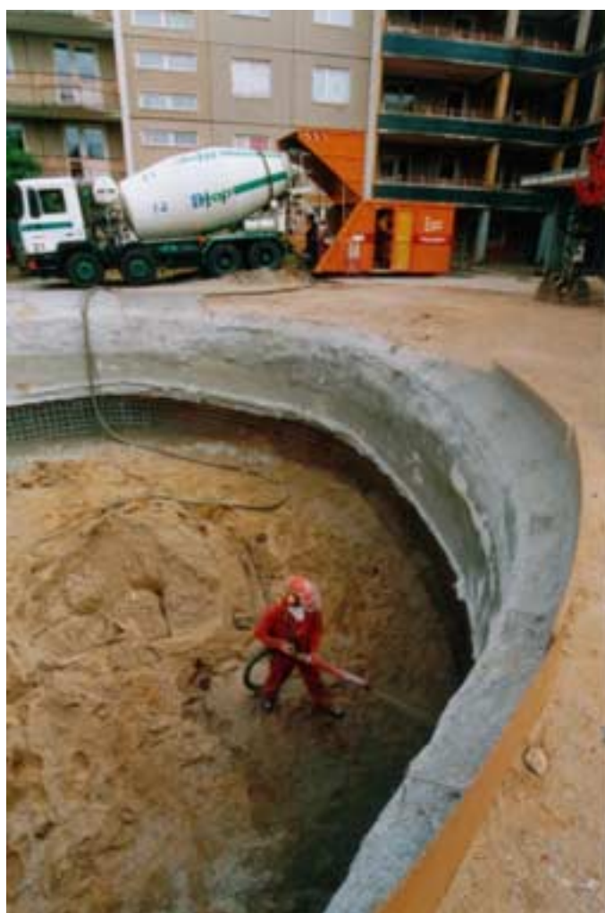
Anlage eines Horizontalfilterbrunnens in Hoyerswerda (Foto: LMBV mbH)
