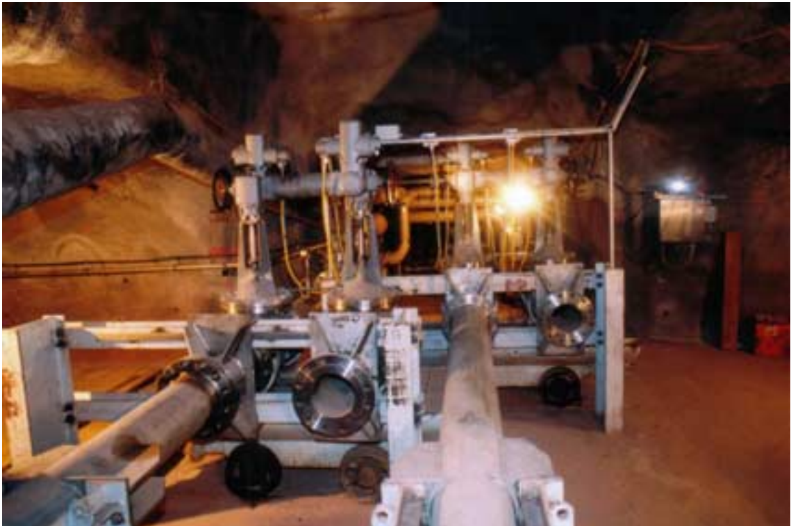
Installation von Grubenwasserbehandlungstechnik in der Grube Königstein (Foto: WISMUT GmbH)
