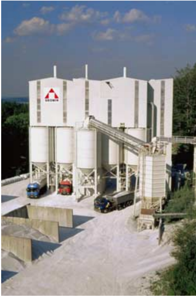
Aufbereitungsanlage am Standort Lengfeld (Foto: GEOMIN GmbH)
